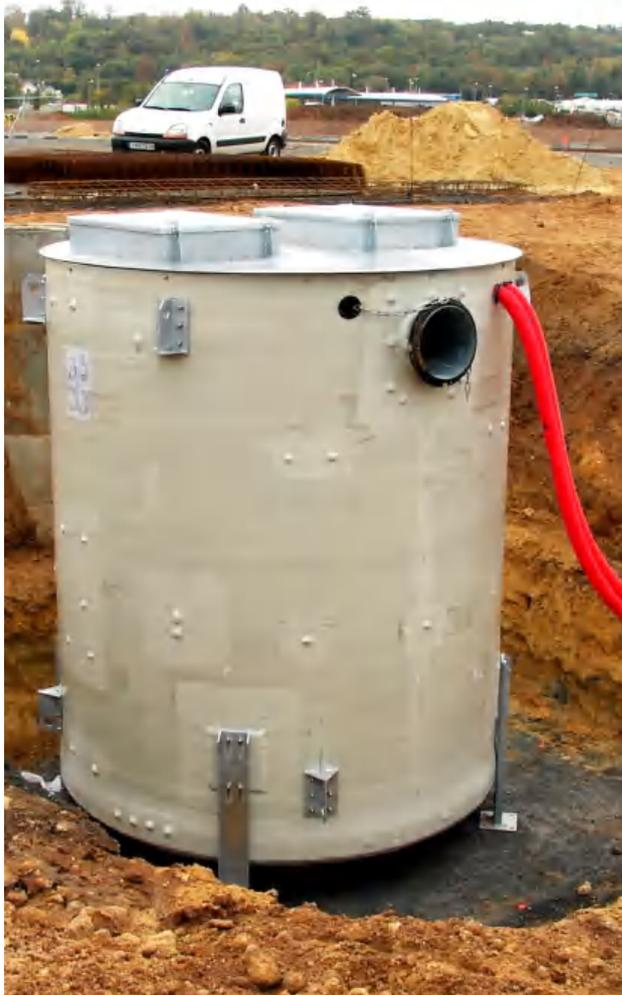
Nous proposons une série de cuves à enterrer conçue pour le relevage et le refoulement des eaux pluviales, des eaux usées, des eaux chargées et des rejets d'usines.
